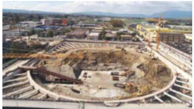
chantier en cours d'exécution
