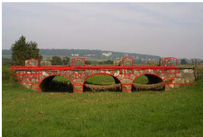
pont avec indication des moellons
