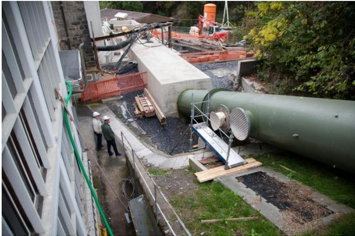
Figure 10. Nouveau massif d'appui PF7, photo en cours de construction
